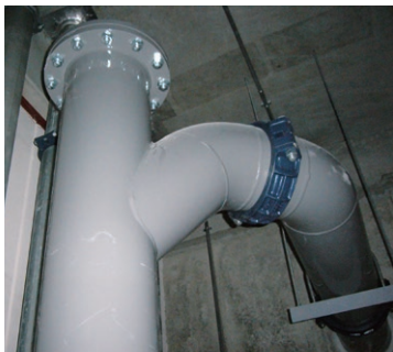
当社でコーティングした配管の施工写真 Photo of construction with pipes we have coated 本公司进行表面涂装的管道的施工照片
