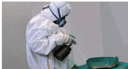
コーティング写真 Photo of coating 涂层作业照片
