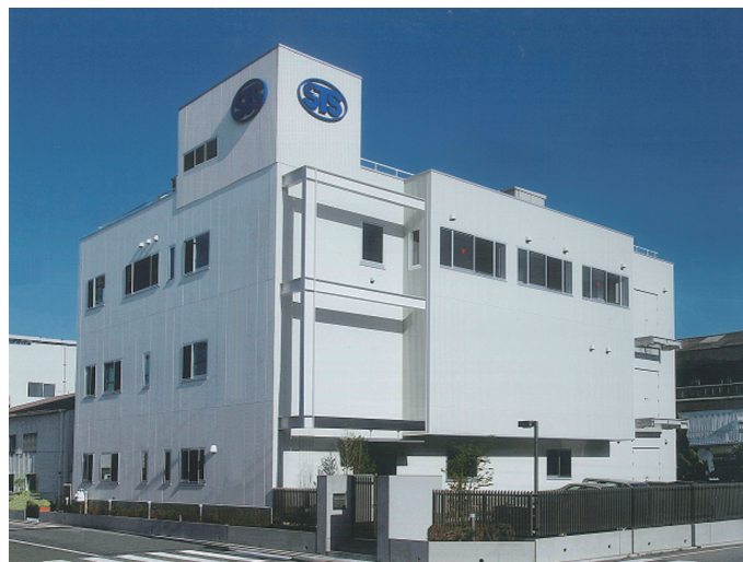
新工場（2016年竣工） New factory (construction completed in 2016)
