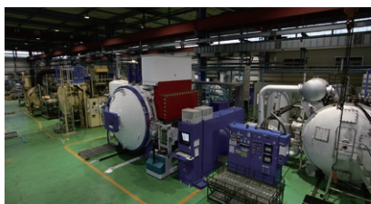
当社の真空熱処理工場 Our vacuum heat treatment plant 本公司真空热处理工厂
